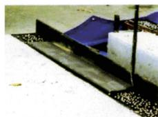
一般市販鋼材は、不等辺山形鋼をお勧めします。不等辺山形鋼端面にφ6程度の丸鋼を溶接することで鋼球の飛散を防止します。
