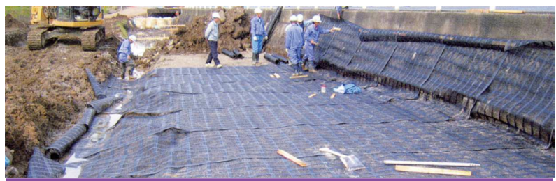
アダムで路床を補強
