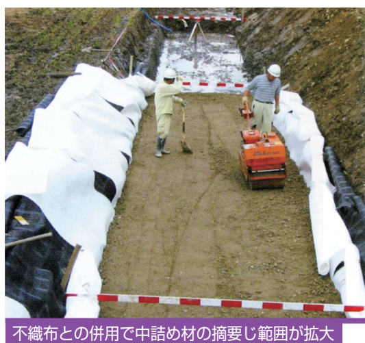
アダムで路床を補強
