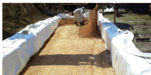
L型擁壁をしっかり支える
