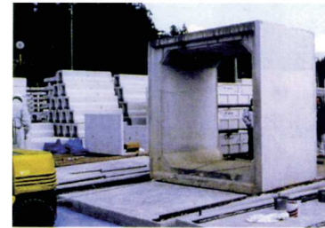
ボックスカルバート滑走状況
