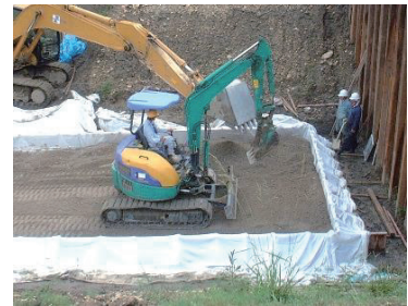
③ 中詰材転圧
