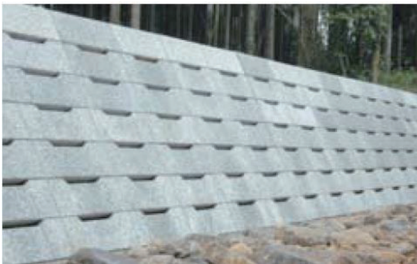
粗面状の表面が景観性に優れ開口部が生態系にも配慮している
