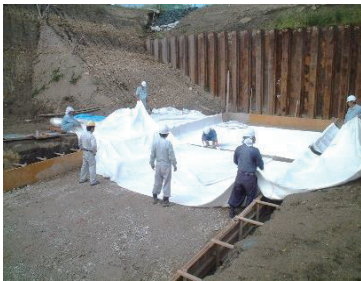
① エーステックス敷設
