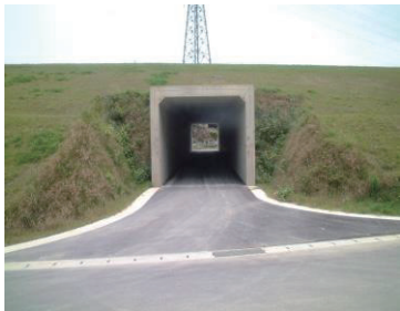
⑥ 上部構造物施工完了
