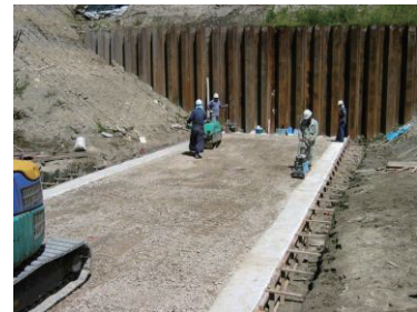
④ 転圧完了
