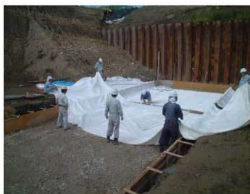
① エーステックス敷設
