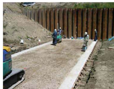
④ 転圧完了
