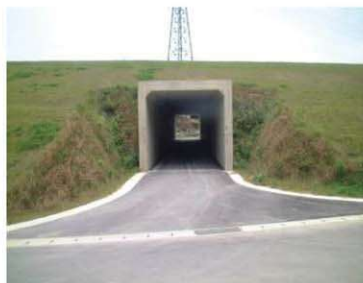
⑥ 上部構造物施工完了
