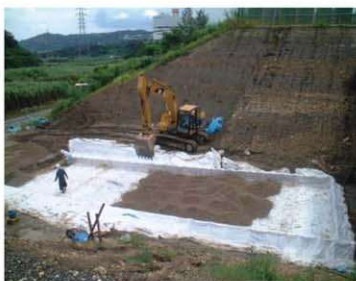
② 中詰材投入
