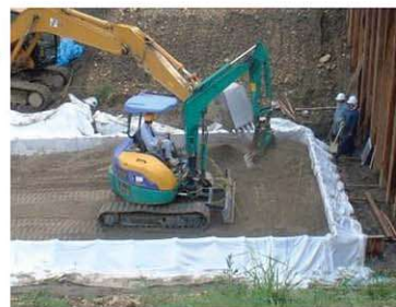
③ 中詰材転圧
